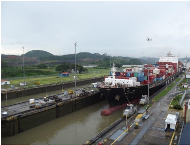
Navio tipo Panamax ocupando integralmente a eclusa. Canal do Panamá, Panamá.
