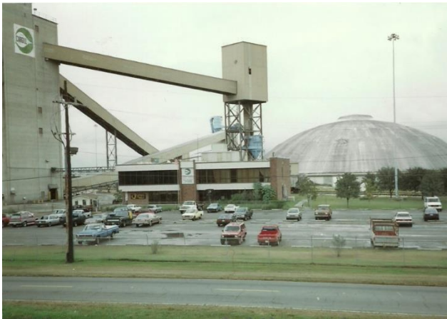
Terminal graneleiro da Cargill no Rio Mississippi. Louisiana, Estados Unidos.
