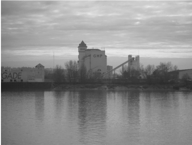
Instalações dos terminais privados do Porto de Bordeaux. Bordeaux, França.
