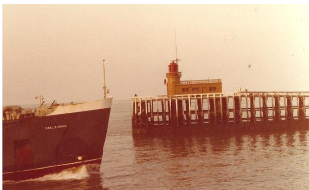
Farol de auxílio à navegação no acesso ao Porto de Calais. França.
