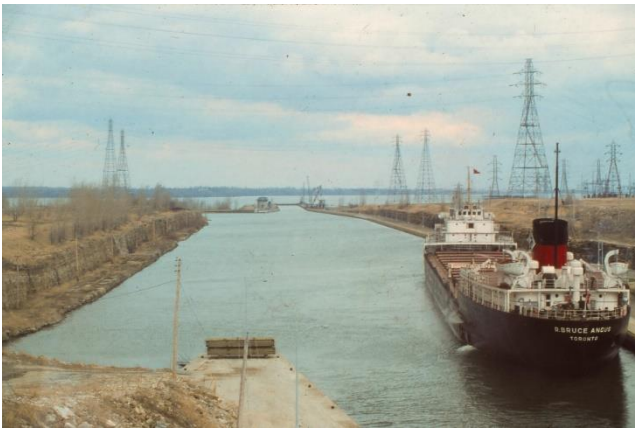
Canal de Saída da Eclusa Beauharnois, do Rio São Lourenço. Canadá.
