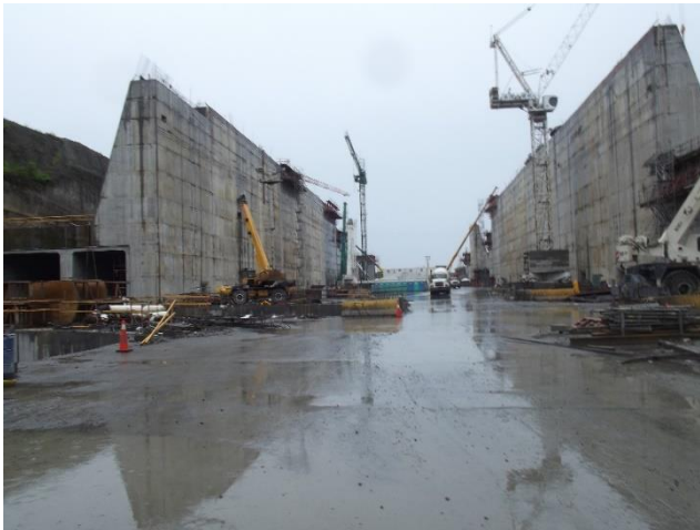
Novas eclusas em construção. Canal do Panamá, Panamá. Foto de Samuel Sembalista Haurelhuk, 2013.
