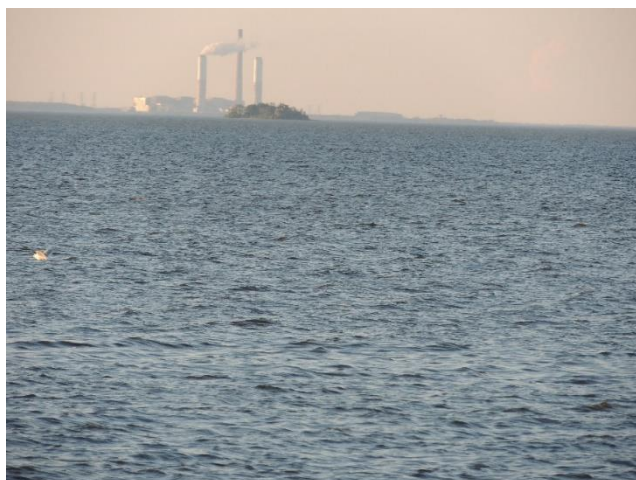
Instalações industriais no Porto de Toledo nas margens do Lago Erie. Toledo, Estados Unidos. Foto de Sílvio dos Santos, 2013
