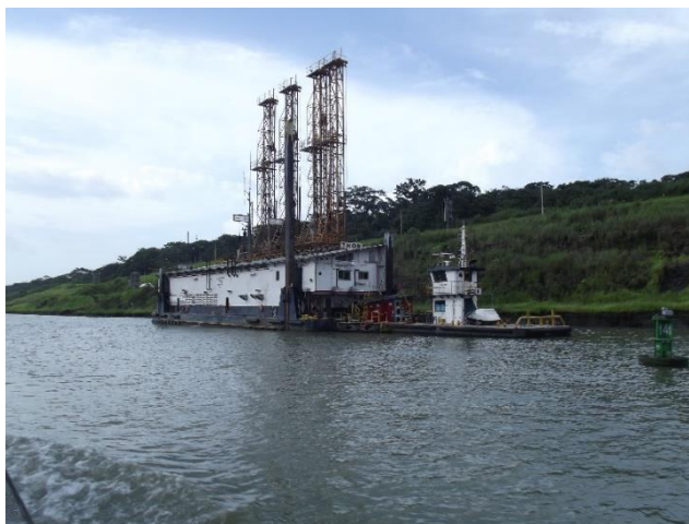
Equipamento do aprofundamento do trecho rochoso. Canal do Panamá, Panamá.
