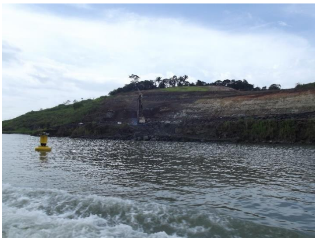
Obras no corte Gaillard. Canal do Panamá, Panamá.
