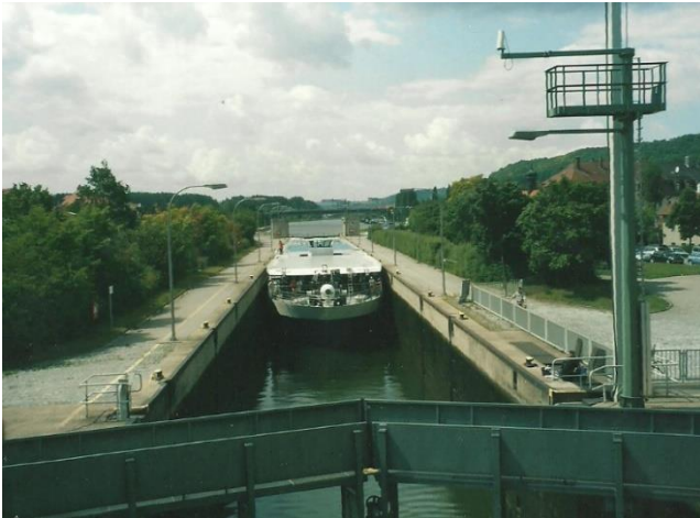
Embarcação de turismo transpando a eclusa de Regensburg no canal lateral do Rio Danúbio. Alemanha.
