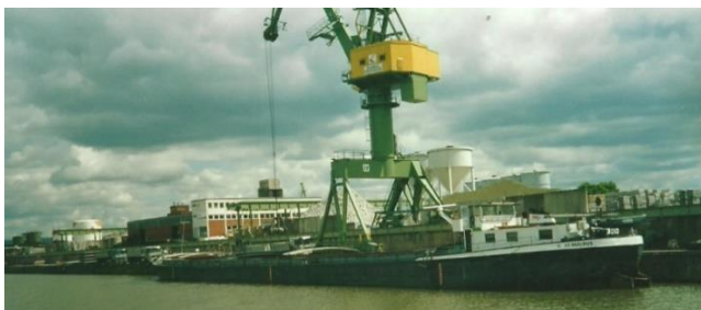
Instalações portuárias de Regensburg no Rio Danúbio. Regensburg, Alemanha.
