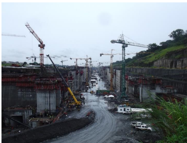
Novas eclusas em construção. Canal do Panamá, Panamá. Foto de Samuel Sembalista Haurelhuk, 2013.
