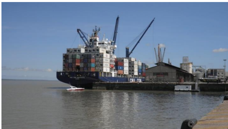
Terminal de contêineres do Porto de Belém. Belém, Brasil. Foto de Sílvio dos Santos, 2010.
