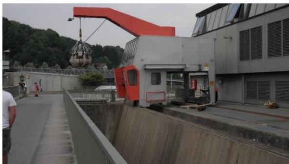
Eclusa de Regensburg com equipamento para retirar objetos flutuantes principalmente troncos de árvores após as grandes chuvas. Alemanha.
