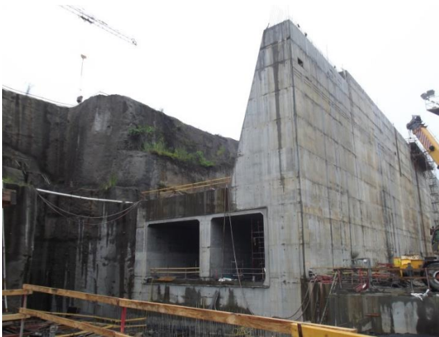
Novas galerias em construção. Canal do Panamá, Panamá. Foto de Samuel Sembalista Haurelhuk, 2013.
