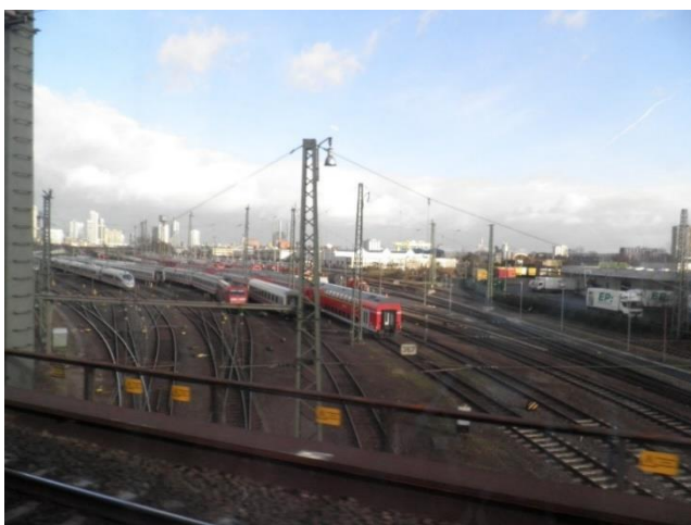
Acesso ferroviário ao Porto de Frankfurt. Alemanha. Foto de Sílvio dos Santos, 2012.
